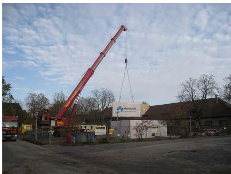
Um die Module mit einem Gesamtgewicht von 4 bis 29,5 Tonnen bewegen zu können, wurde auf dem Gelände Moltkestrasse 120 bereits am vergangen Montag ein 300 Tonnen schwerer Mobilkran aufgebaut. Mit dessen Hilfe wurde aus 11 Modulen das Erdgeschoss und aus weiteren
