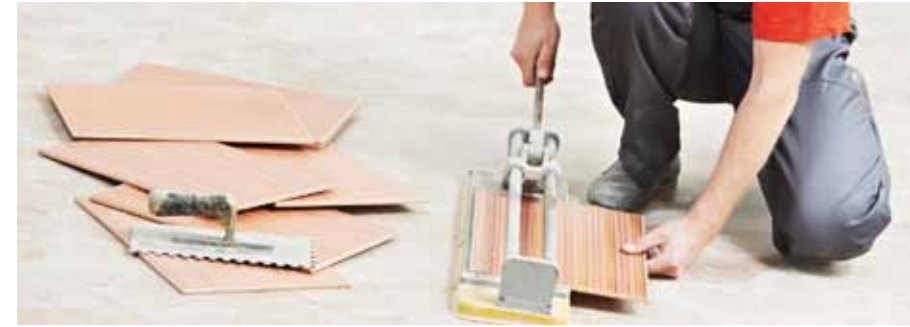
Je genauer, desto besser das Ergebnis: Fliesenlegen ist Maßarbeit
