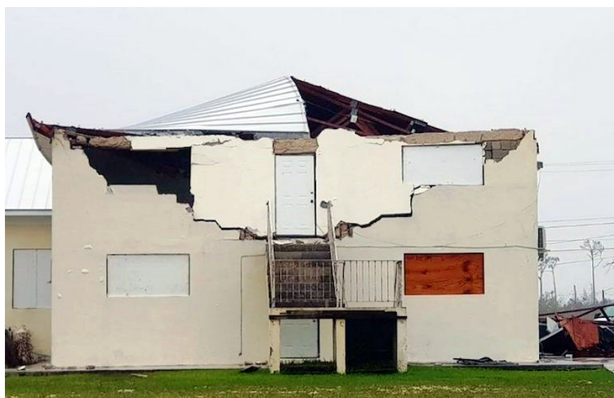
Zerstörung an Fassade und Dach der Freeport Adventist Church in Freeport, Grand Bahama © Foto: Eric D. Clarke/ATCU
