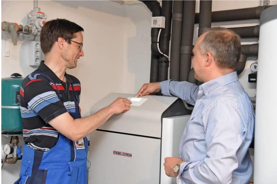
Auch SHK-Installateure setzen auf moderne Heiztechnik in den eigenen vier Wänden: Hier wurde der bestehende Gaskessel durch eine Erdschicht-Wärmepumpe WPF 16 von STIEBEL ELTRON ersetzt.
