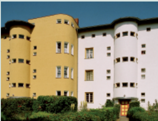
oben: Luftbild, um 1928 unten: Der von Martin Wagner entworfene Block an der Stavenhagener Straße, Zustand nach Sanierung 2000 Foto: WINFRIED BRENNE ARCHITEKTEN
