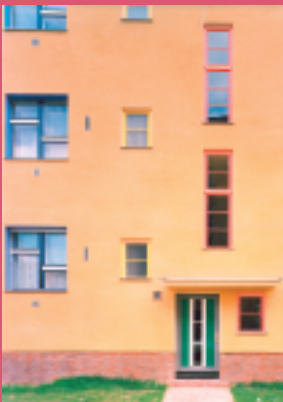
oben: Blick in die Erich Weinert Straße, um 1930 Foto: Arthur Köster, © VG Bild-Kunst, Bonn 2007 unten: Hellgelbe Straßenfassade mit farbig gefaßten Fenstern und Türe, Zustand nach Sanierung 1997 Foto: WINFRIED BRENNE ARCHITEKTEN
