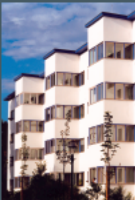
oben: Blick über die Siedlung, um 1930 unten: Verglaste Loggien im Bauteil Bruno Ahrends, Zustand nach Sanierung 2002 Foto: WINFRIED BRENNE ARCHITEKTEN
