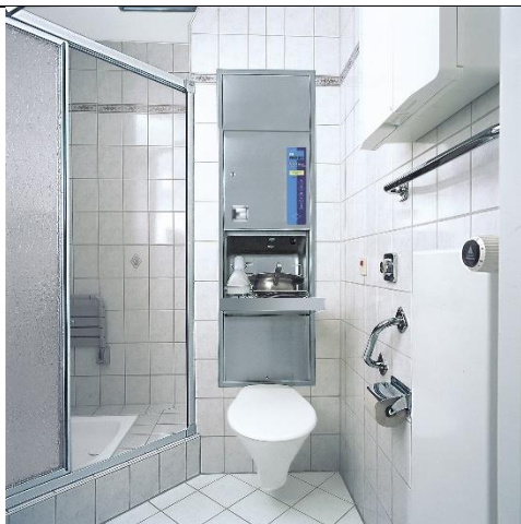
Patientenbad mit Dusche, Toilette und Steckbeckenspülgerät TopLine von Meiko
