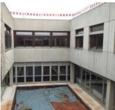
Gesamtschule Wetter vor der Sanierung Bilder: Rubner Holzbau
