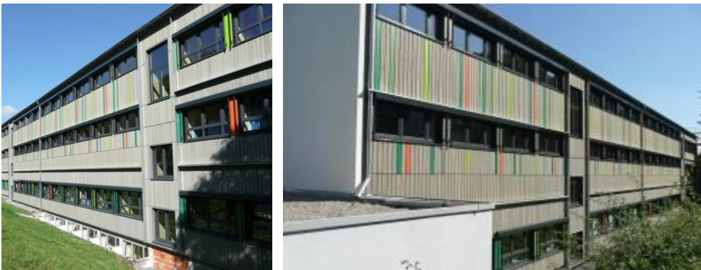
Grundschule Treuchtlingen nach der Sanierung
