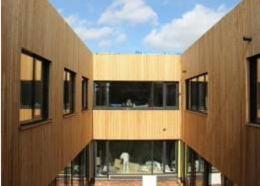
Gesamtschule Wetter nach der Sanierung Bilder: Rubner Holzbau
